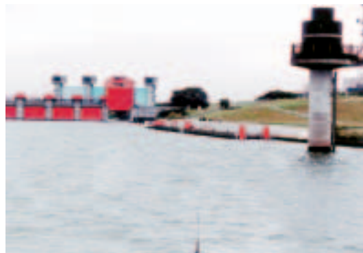
写真-1 河川緊急用船着場(荒川・東京都岩淵)
